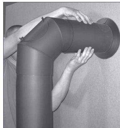
**Bitte überprüfen Sie die Dichtheit der Verrohrung durch ein kurzes Probeheizen mit wenig Brennstoff. Dichten Sie die Rauchrohr-Verbindungsstellen mit Kesselkitt nochmals ab, falls dieses erforderlich sein sollte.**
