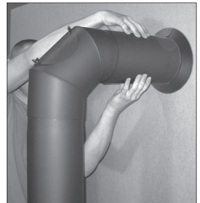
**Bitte überprüfen Sie die Dichtheit der Verrohrung durch ein kurzes Probeheizen mit wenig Brennstoff. Dichten Sie die Rauchrohr-Verbindungsstellen mit Kesselkitt nochmals ab, falls dieses erforderlich sein sollte.**
