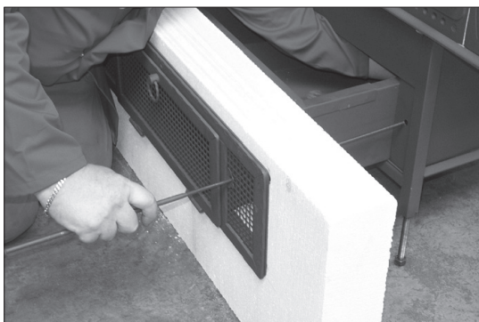
Bild 2-9 Sockel mit Zuluftöffnung 1 Kamineinsatz 2 Sockel 3 Ausschnitt Aschenlade 4 Aschenladenblende
