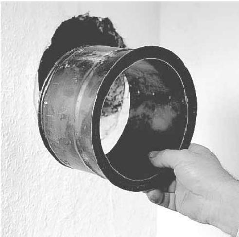
Setzen Sie das doppelwandige Wandfutter in das Schamotterrohr bzw. -formteil mit feinem Schamottemörtel außen bündig ein. Streichen Sie die Anschlussstellen mit einem feuchten Schwamm glatt heraus. Achten Sie darauf, dass keine Schamottereste hervorstehten.
