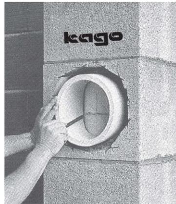
Schneiden Sie die angezeichnete Kreisfläche wie in nebenstehendem Bild dargestellt mit einer Flex aus. Alternativ können Sie die Öffnung auch mit der Bohrmaschine ausbohren:
