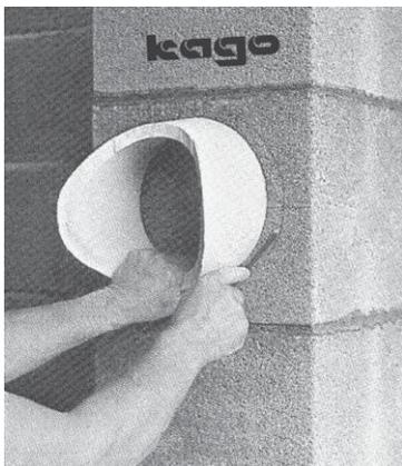
Schneiden Sie die erforderliche Öffnung vorsichtig aus. Entfernen Sie etwaig vorhandenes Dämmmaterial zwischen Mantelstein und Innenrohr.
