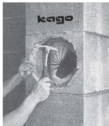
Feuchten Sie das Schamotterohr um die vorhandene Öffnung bzw. das Formteil an und geben Sie den Säuremörtel bzw. Keramikkleber auf das Formteil. Setzen Sie das Schamotteformteil satt und bündig an die hergestellte Öffnung an. Das Formteil ist so einzusetzen, wie die Rauchrohrführung verläuft.
