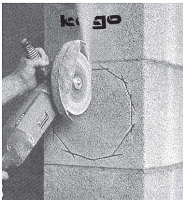
Setzen Sie das Schamotteformteil trocken an das Schamotterohr des Rauchzuges an. Zeichnen Sie den Innendurchmesser des Schamotteformteiles am Schamotterohr an.
