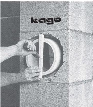
Pressen Sie das Formteil am Innenrohr an und verstreichen Sie ausquellenden Kitt. Füllen Sie die Fuge zwischen Schamotteformteil und Mantelstein mit Steinwolle aus. Achten Sie darauf, dass das gesetzte Formteil fest ist. Berücksichtigen Sie die Aushärtezeit.
