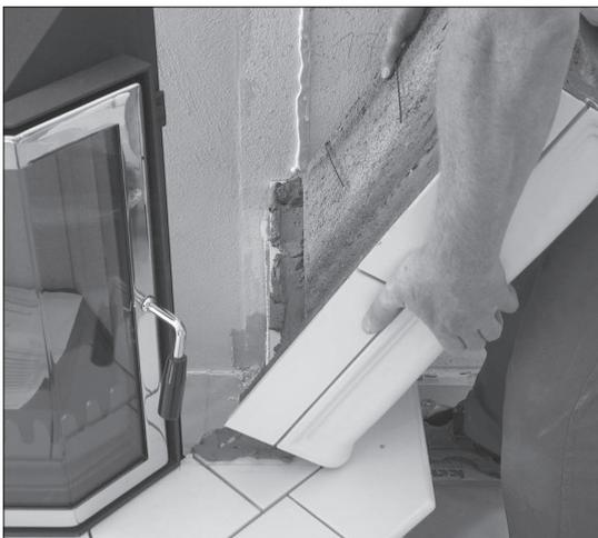
**Achten Sie bei der Positionierung der Ofenteile darauf, dass diese nicht unmittelbar direkt am Kamineinsatz anliegen. Es muss sichergestellt sein, dass umlaufend um den Kamineinsatz eine Fuge von ca. 5 mm verbleibt, damit sich das Heizgerät ausdehnen kann.**
