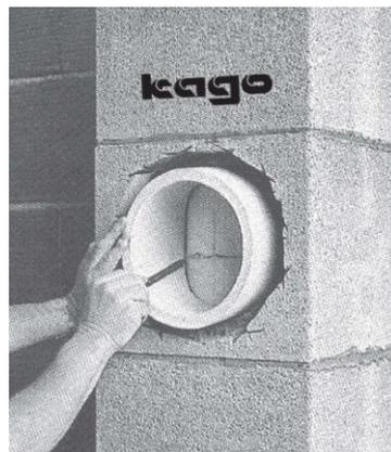
Schneiden Sie die angezeichnete Kreisfläche wie in nebenstehendem Bild dargestellt mit einer Flex aus. Alternativ können Sie die Öffnung auch mit der Bohrmaschine ausbohren: Bohren Sie entlang der angezeichneten Kreislinie in kleinen Abständen vorsichtig Loch neben Loch. Verwenden Sie dazu einen Steinbohrer mit nicht mehr als 10 mm Stärke.
